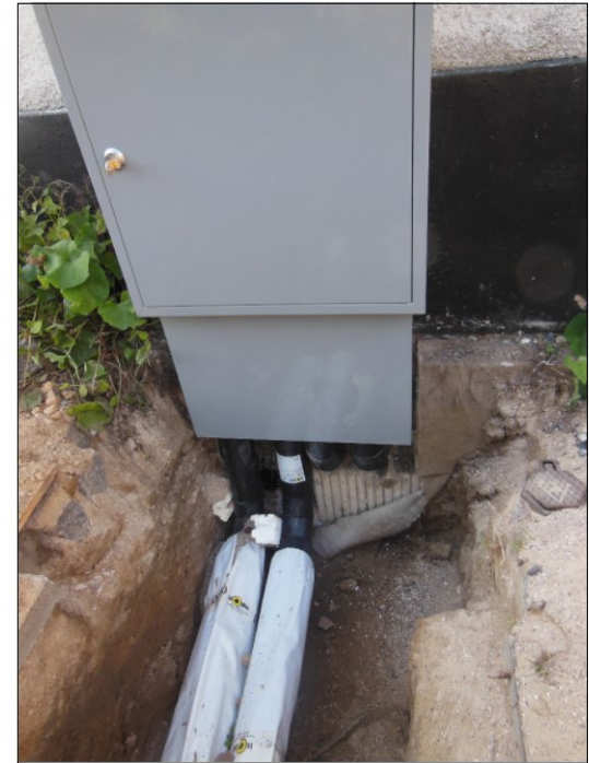
Dobbelt skab på facade, med indføring i kælder
