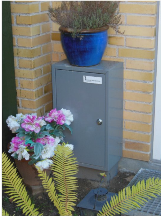
Skab på facade
